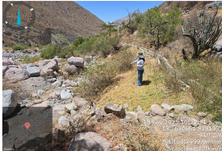
FIGURA N°02: CANAL DE REGADIO IRURUPA II, NO CUENTA CON UNA PROTECCION FRENTE A AVENIDAS
