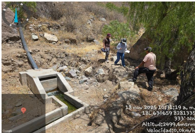
FIGURA N°03: EL AGUA ES TRASLADADO MEDIANTE TUBERIA HDPE HACIA UNA CAIDA PARA DISTRIBUIR MEDIANTE EL CANAL AL SECTOR DE IRURUPA
